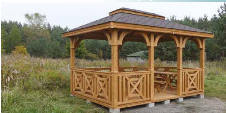
Wykonanie altany na potrzeby integracyjne mieszkańców w Fugasówce
