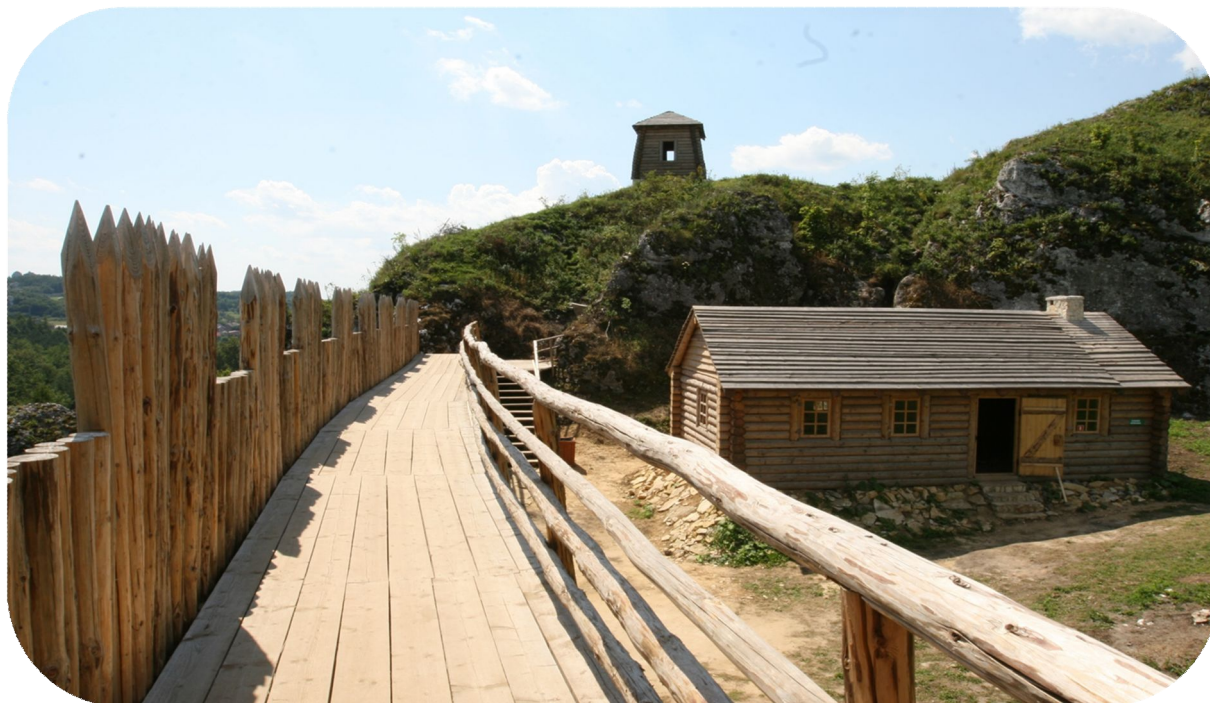
Rekonstrukcja Grodu na Górze Birów w Podzamczu
