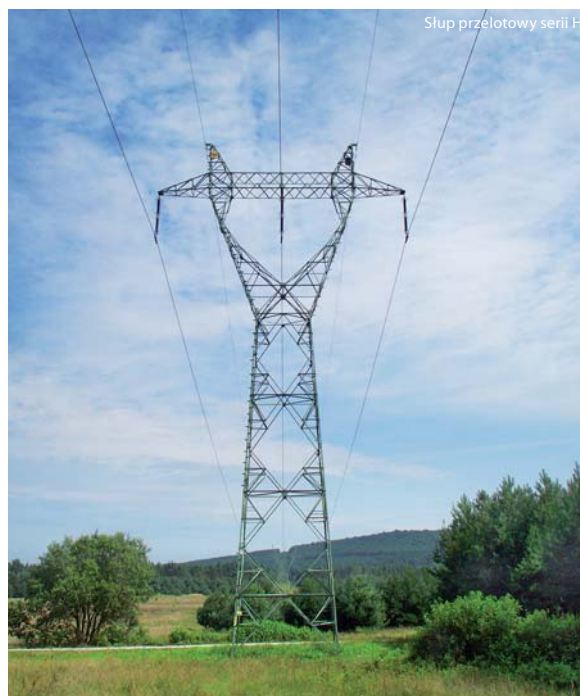
Linia elektroenergetyczna 220 kV relacji Łośnice – Kielce
